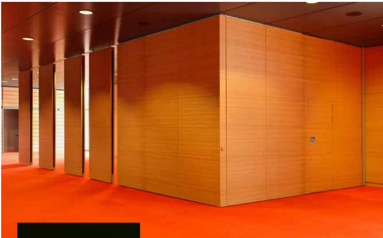
Tabiques Móviles Monodireccionales o Multidireccionales, sin guía en el suelo y carril encastrado en el falso techo. Módulos telescópicos e independientes.
